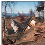
Anchorage, Alaska. Terremoto de 1964, licuación y expansión lateral. No licuación en MGCS (distinta litología y no saturada).
