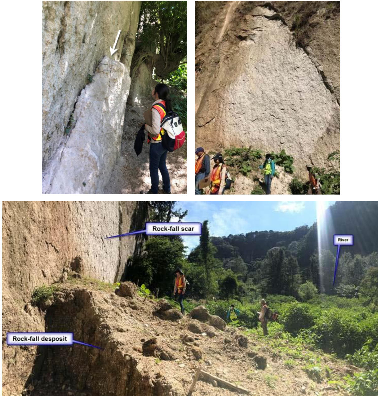
Figura 4-21. Meteorización de los flancos desnudos de los cañones, desprendimiento de bloques y caída de rocas.
