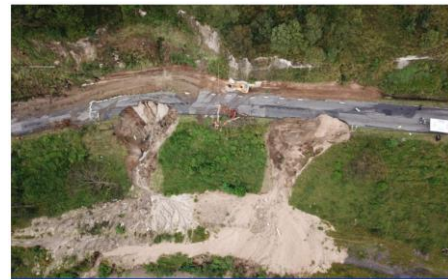
Nuevo deslave en bajada de San Cristóbal y Villalobos complica trabajos de reconstrucción
