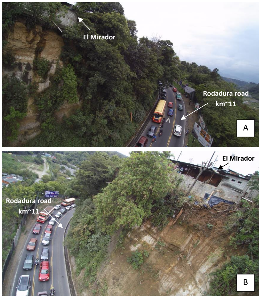
Figura 2-2. Km 11 Carretera Rodadura y casas del barrio El Mirador afectadas por derrumbes, mirando al sur (A) y al norte (B). Observe los numerosos tubos hacia la pendiente. Imágenes tomadas con dron en mayo de 2018.
