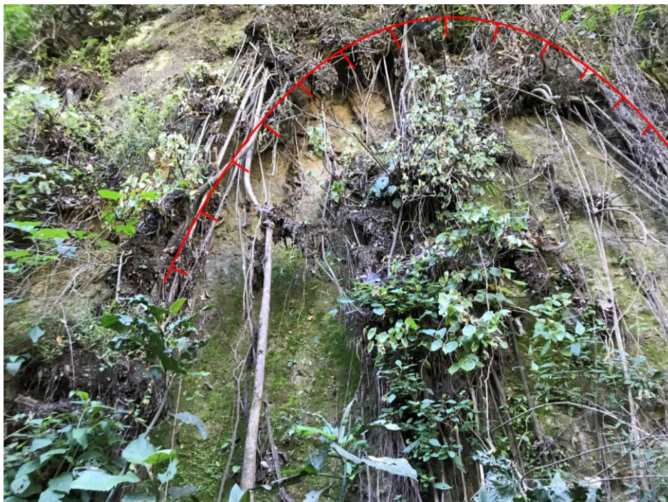
Figura 4-20. Caídas de rocas provocadas por la meteorización física de las raíces a lo largo de los flancos de los cañones con vegetación.
