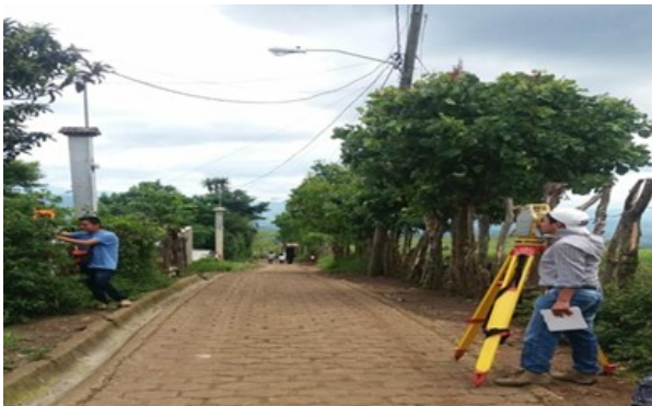
c. Practica en campo del uso del equipo topográfico tipo estación total
