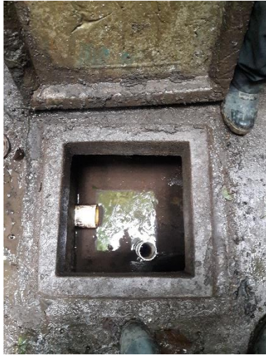
Foto 3. Caja de captación de agua de manantial.
