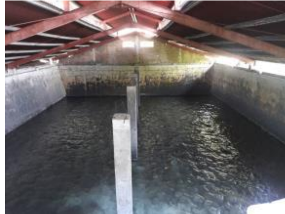
Foto 36. Tanque de almacenamiento de agua proveniente del pozo Capri y el pozo del Cementerio
