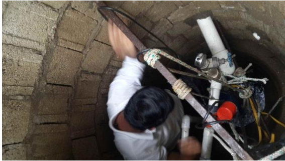
Foto 23. Interior del pozo de la colonia Lomas de SC Pinula, revestimiento de block. El pozo no cuenta con sello de seguridad.
