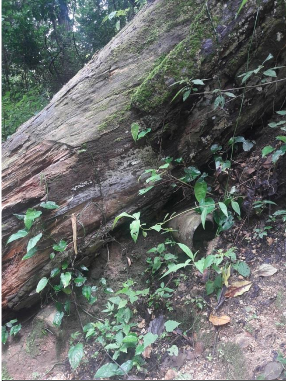
Foto 20. Tubería afectada por la caída de un árbol en una ladera con alta pendiente
