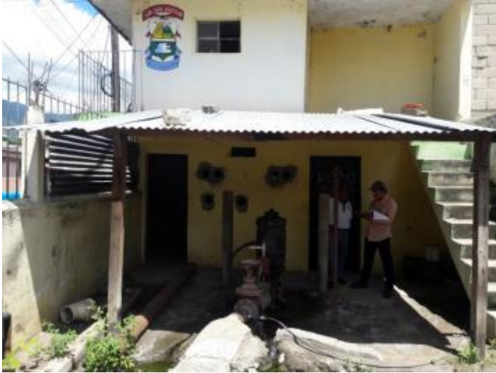
Foto 32. Pozo municipal ubicado en cercanías del río Michatoya, bombea actualmente agua con influencia termal y el agua presenta valores elevados de Cl - ; Na; y Arsénico (As), con valores por encima de la norma guatemalteca para agua de consumo humano COGUANOR 29001 .
