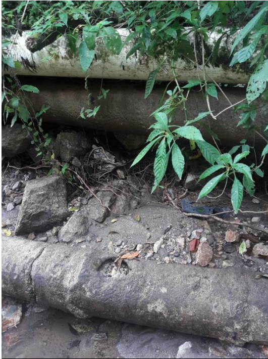
Foto 18. Sucesión histórica de los tipos de tubería que han funcionado, se observa la más antigua, tubería de arcilla conglomerada (sin referencia), seguida de tubería de hierro forjado (principios de 1900 hasta 1948). Encima de ella, la tubería más reciente de PVC, instalada en 2017.
