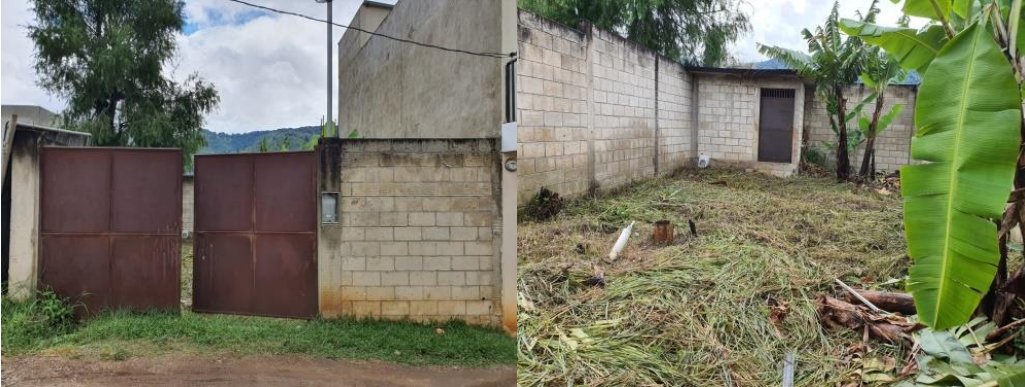
Figura 57. Fachada del lugar donde se encuentra el pozo.
