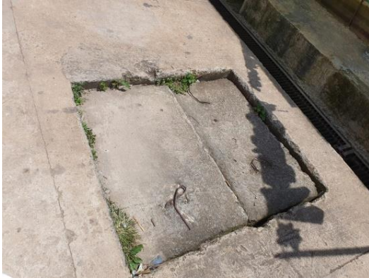
Figura 88. Vista exterior del lugar en donde se encuentra el pozo en medio y por debajo de la calle, con todo su equipo.
