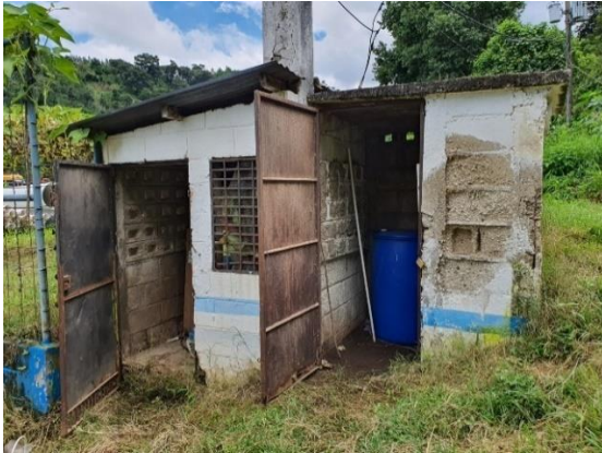
Figura 103. Fachada del lugar de ubicación del pozo y caseta donde se encuentra el sistema eléctrico y de cloración.
