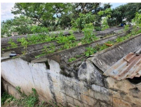
Figura 100. Vista superior del tanque de almacenamiento que brinda servicio a los pozos Morancito I y II.
