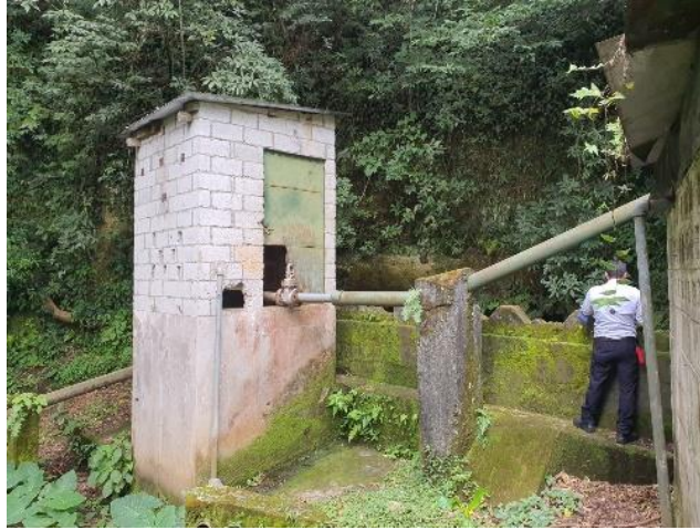
Figura 134. Caseta donde se encuentra el sistema de bombeo y motor para impulsar agua hacia el tanque de almacenamiento.
