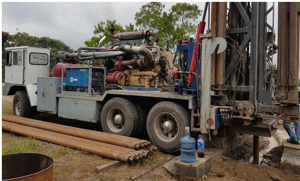
Figura 3. Equipo mecánico para perforación de pozo
