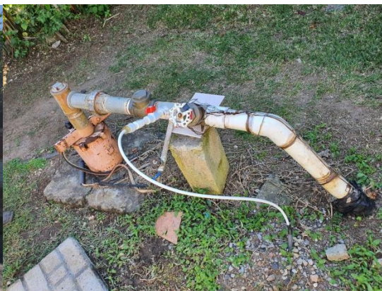
Figura 80. Tubería externa y sello sanitario del pozo.
