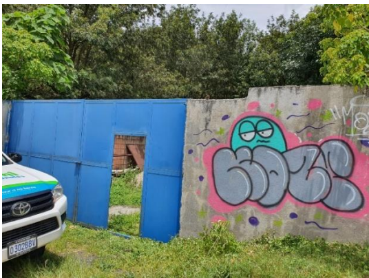
Figura 140. Fachada del lugar de ubicación del pozo.
