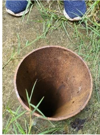
Figura 69. Vista superior del pozo con su tubería de encamisado, se escucha que en su interior posee agua.
