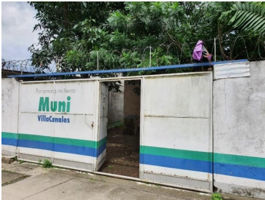
Figura 112. Fachada del lugar de ubicación del pozo.
