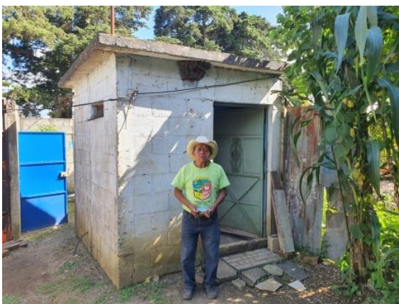
Figura 81. Caseta donde se encuentra el equipo eléctrico y de cloración.
