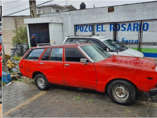
Figura 33. Predio del pozo es utilizado como parqueadero por los vecinos por falta de protección y resguardo. Al fondo caseta donde se encuentra equipo de cloración y sistema eléctrico.
