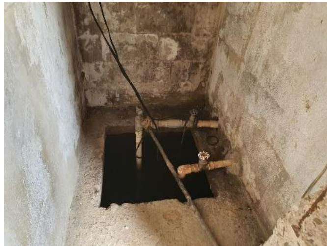
Figura 78. Vista interior del tanque de almacenamiento.
