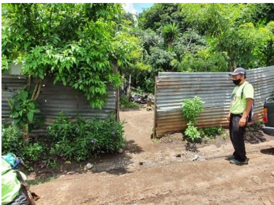
Figura 72. Vista exterior del lugar de ubicación de los pozos.
