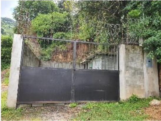
Figura 75. Fachada del lugar de ubicación del pozo.
