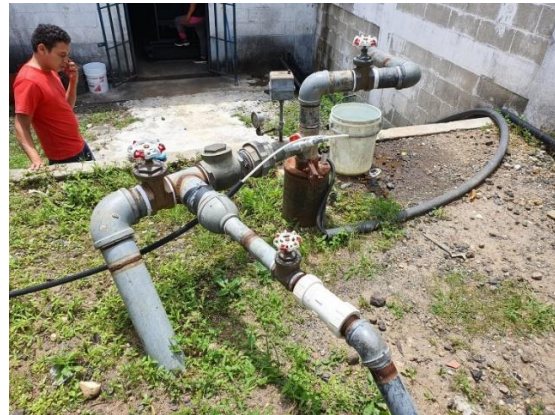
Figura 131. Tubería externa y sello sanitario del pozo.
