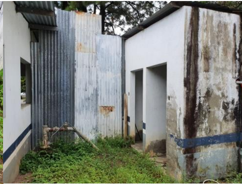
Figura 43. Al fondo tubería externa del pozo, al lado izquierdo aula de escuela y al lado derecho caseta con equipo de cloración y eléctrico.
