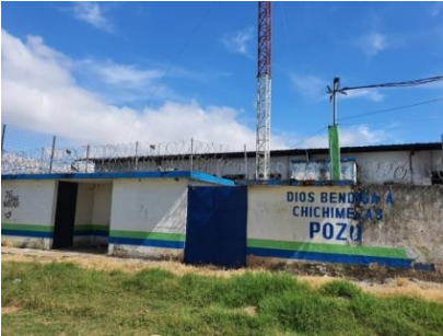
Figura 91. Fachada exterior donde se encuentra el pozo.
