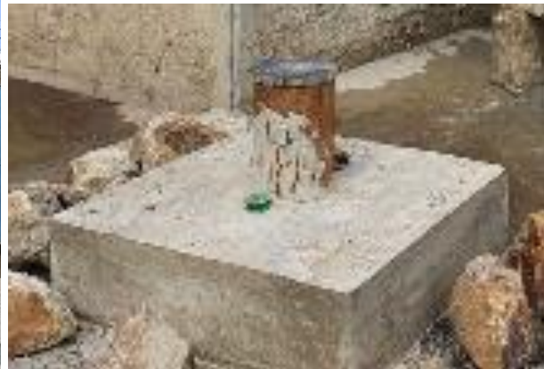
Figura 67. Pozo perforado con su tubería de encamisado ya instalada.
