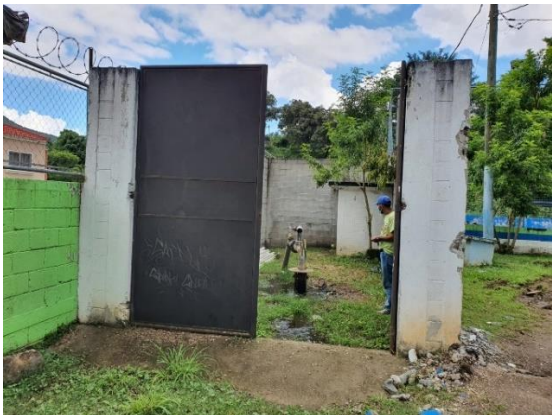
Figura 105. Fachada del lugar de ubicación del pozo. Al fondo caseta con sistemas eléctricos y de cloración.
