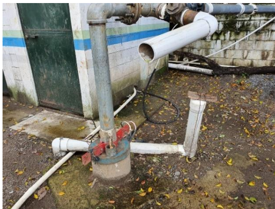
Figura 102. Tubería externa y sello sanitario del pozo.
