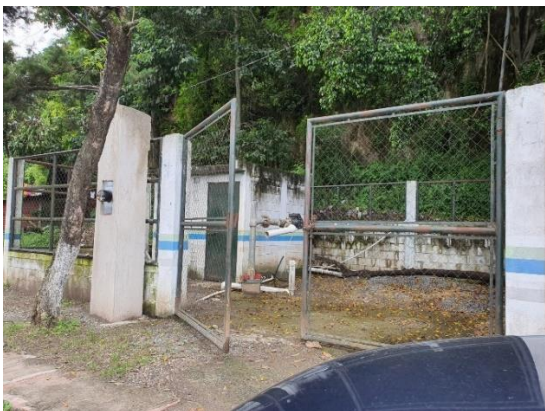
Figura 101. Vista exterior del lugar de ubicación del pozo. Al fondo caseta con sistemas eléctricos y de cloración.
