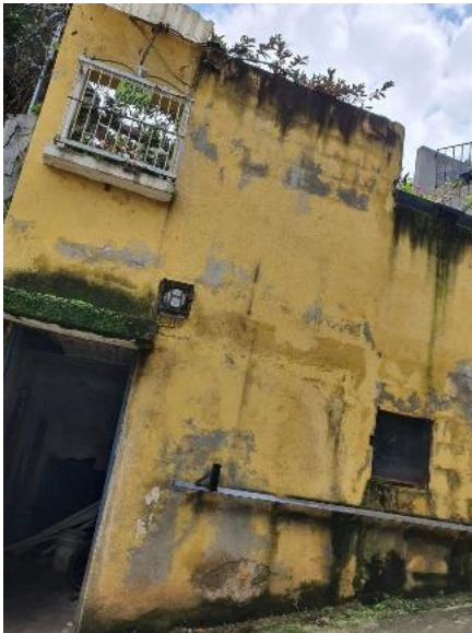
Figura 77. Vista exterior del tanque de almacenamiento conectado al pozo.
