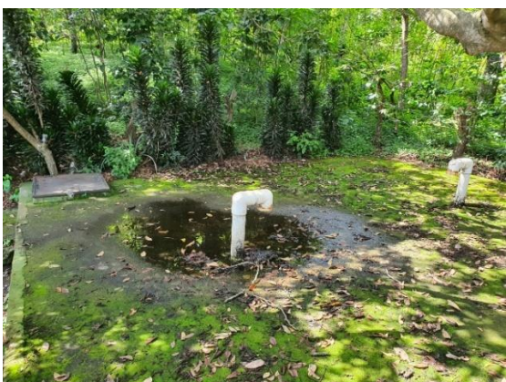
Figura 145. Vista superior del tanque cisterna del pozo.
