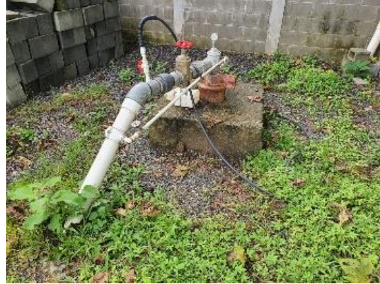
Figura 76. Tubería externa y sello sanitario del pozo.
