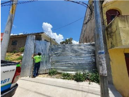
Figura 60. Fachada de ingreso a pozo. En su interior se encuentra pozo y caseta con elementos eléctricos y de cloración.
