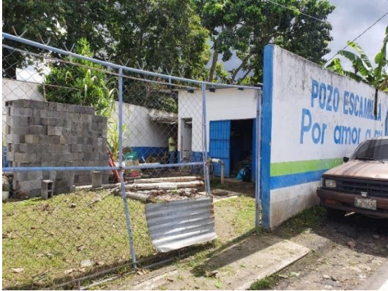
Figura 107. Vista exterior del lugar de ubicación del pozo. Al fondo, caseta con sistemas eléctricos y de cloración.
