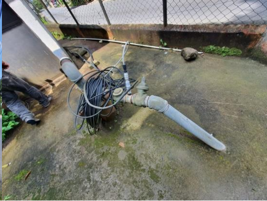
Figura 116. Tubería externa y sello sanitario del pozo.
