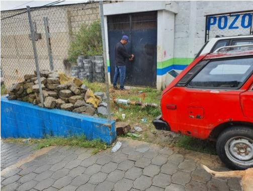
Figura 32. Vista exterior del pozo, al fondo caseta donde se encuentra equipo de cloración y sistema eléctrico.
