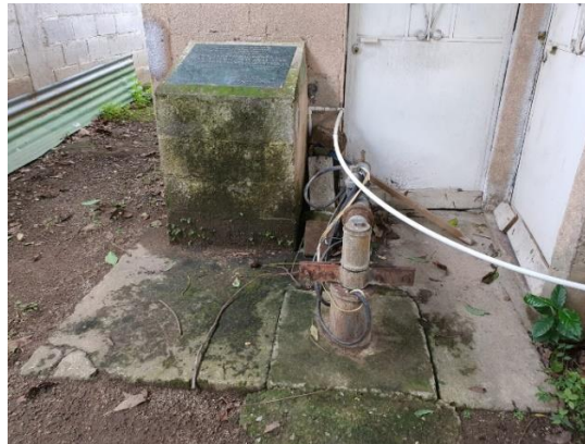
Figura 113. Tubería externa y sello sanitario del pozo.
