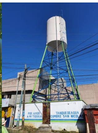
Figura 82. Fachada del lugar en donde se encuentra el tanque elevado para almacenamiento de agua.
