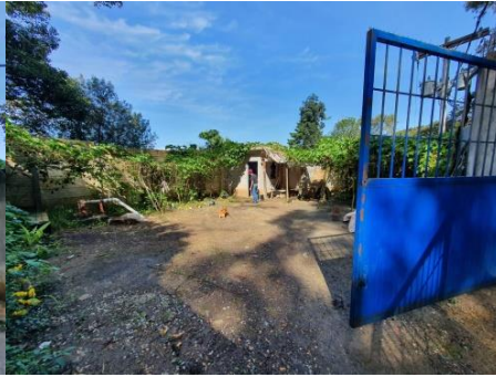
Figura 126. Al costado derecho tubería externa y sello sanitario del pozo, y al costado izquierdo caseta y tanque.
