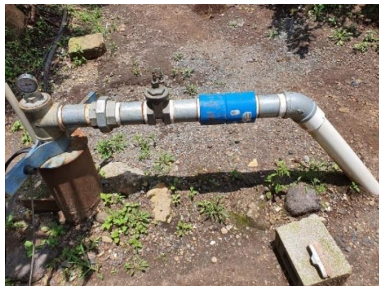
Figura 73. Tubería externa y sello sanitario del pozo.
