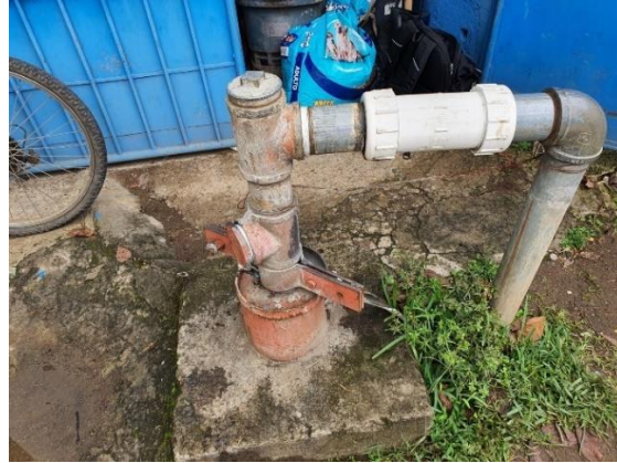
Figura 108. Tubería externa y sello sanitario del pozo.
