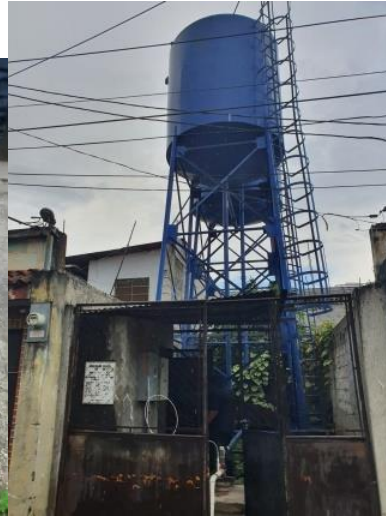
Figura 50. Vista exterior del pozo. Al fondo sus dos tanques elevados.
