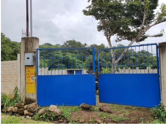
Figura 163. Fachada de la ubicación del tanque de almacenamiento del pozo.
