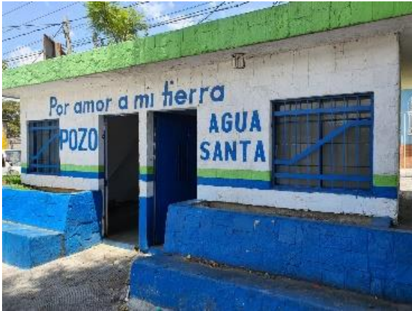
Figura 59. Caseta donde se encuentra elementos de cloración y eléctricos del pozo.
