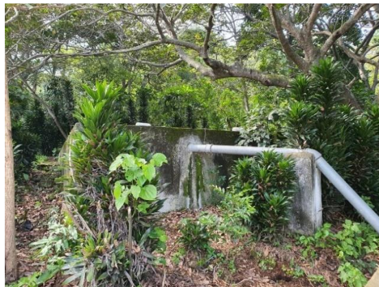
Figura 146. Fachada exterior del tanque de almacenamiento del pozo
