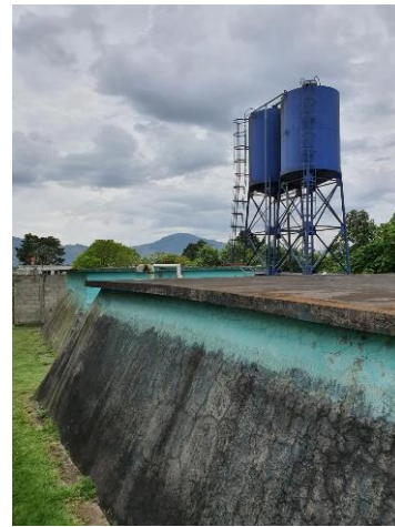
Figura 136. Tanques superficiales y tanques elevados que almacenan el agua extraída.
