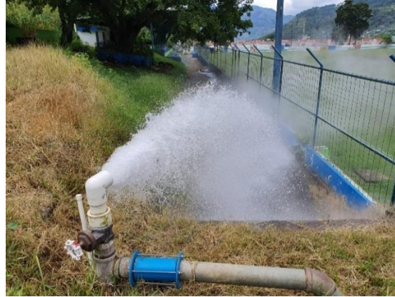
Figura 104. Tubería externa y sello sanitario del pozo.
