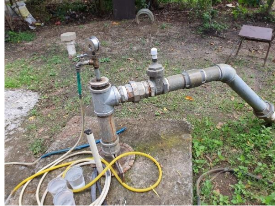
Figura 71. Tubería externa y sello sanitario del pozo.
