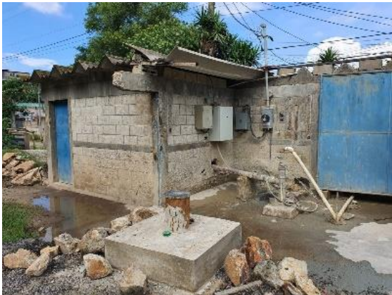
Figura 66. Al frente, vista del lugar en donde se encuentra el pozo perforado "Santana II", y al fondo, caseta donde se encuentran elementos de cloración del pozo "Santana I" y en la parte exterior los tableros eléctricos.
