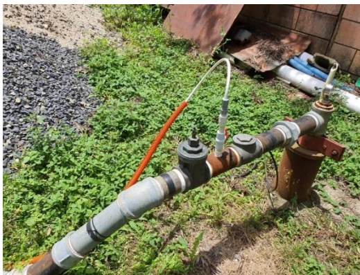
Figura 141. Tubería externa y sello sanitario del pozo.
