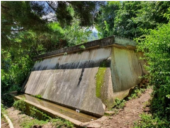
Figura 64. Fachada exterior del tanque cisterna del pozo
