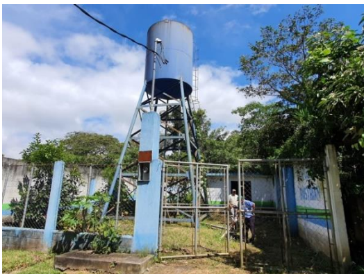
Figura 86. Fachada del lugar en donde se encuentra el pozo. Al fondo caseta donde se encuentra el equipo eléctrico y de cloración.
