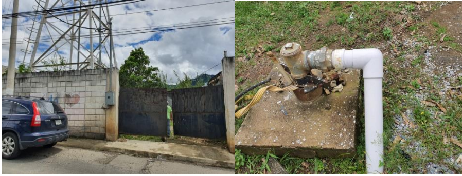
Figura 37. Tubería externa y sello sanitario del pozo.
