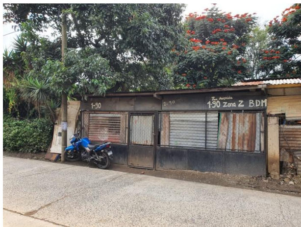
Figura 31. Predio invadido. Dentro del mismo se encuentra la tubería del anterior “pozo la Séptima I”.
