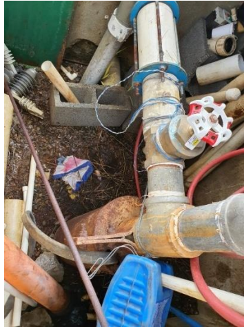
Figura 111. Tubería externa y sello sanitario del pozo.
