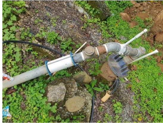
Figura 138. Tubería externa y sello sanitario del pozo.
