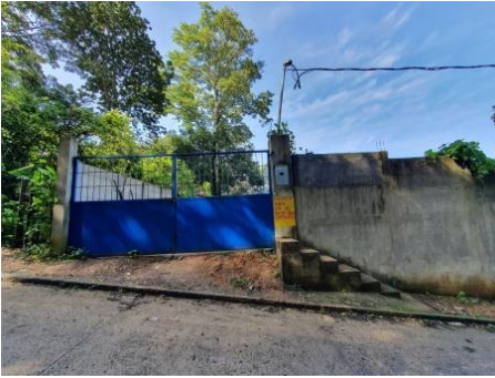
Figura 125. Fachada del lugar de ubicación del pozo.
