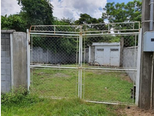
Figura 153. Fachada del lugar de ubicación del pozo. Al fondo caseta con sistema eléctrico y de cloración.
