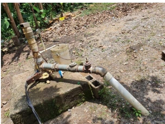
Figura 74. Tubería externa y sello sanitario del pozo.
