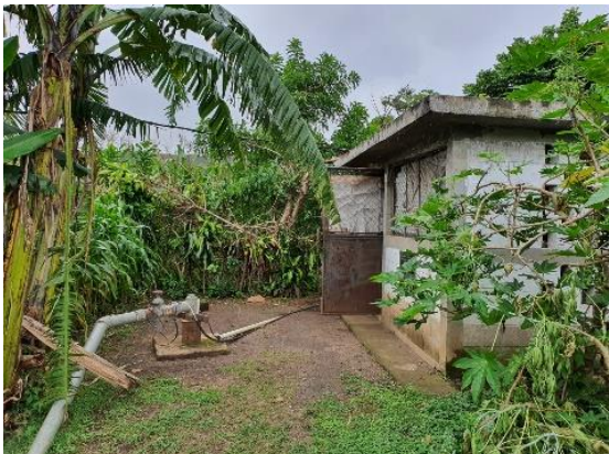
Figura 147. Fachada del lugar de ubicación del pozo. Al lado izquierdo, tubería externa y sello sanitario del pozo y al lado derecho caseta donde se encuentra el sistema eléctrico y de cloración.
