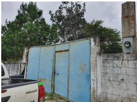
Figura 155. Fachada exterior del lugar de ubicación del pozo.
