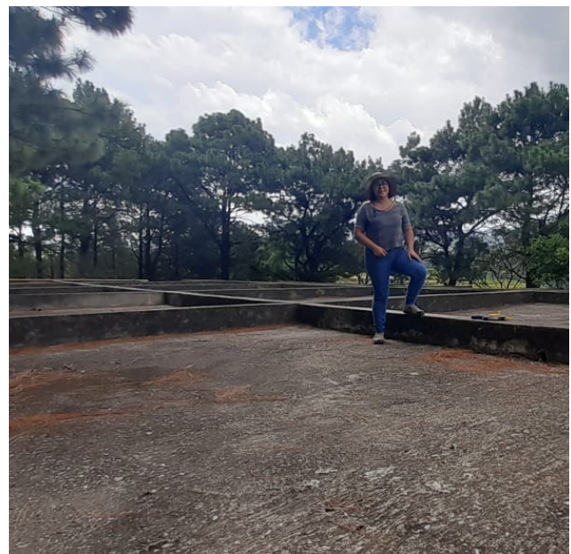
Ilustración 1: Visita de campo a tanque superficial de almacenamiento de la colonia Ribera del Río.
