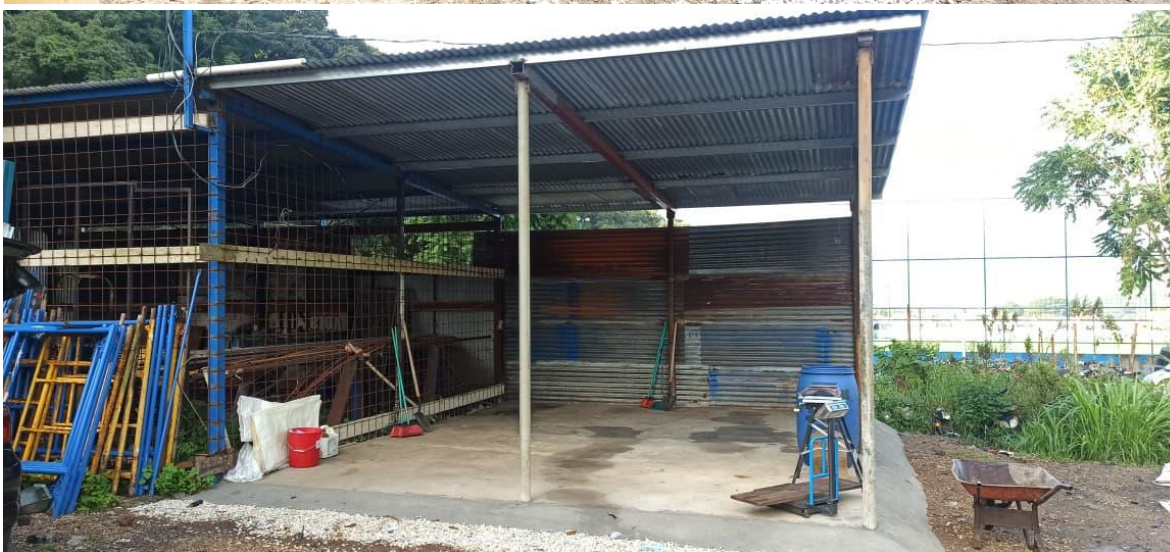
Área para estudio de Caracterización de residuos y desechos sólidos comunes.
