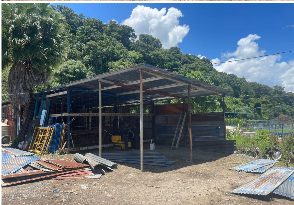
Adecuación de espacio para los trabajos de caracterización
